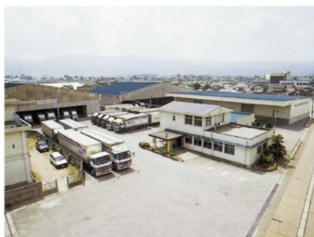
本社 良川営業所全景
